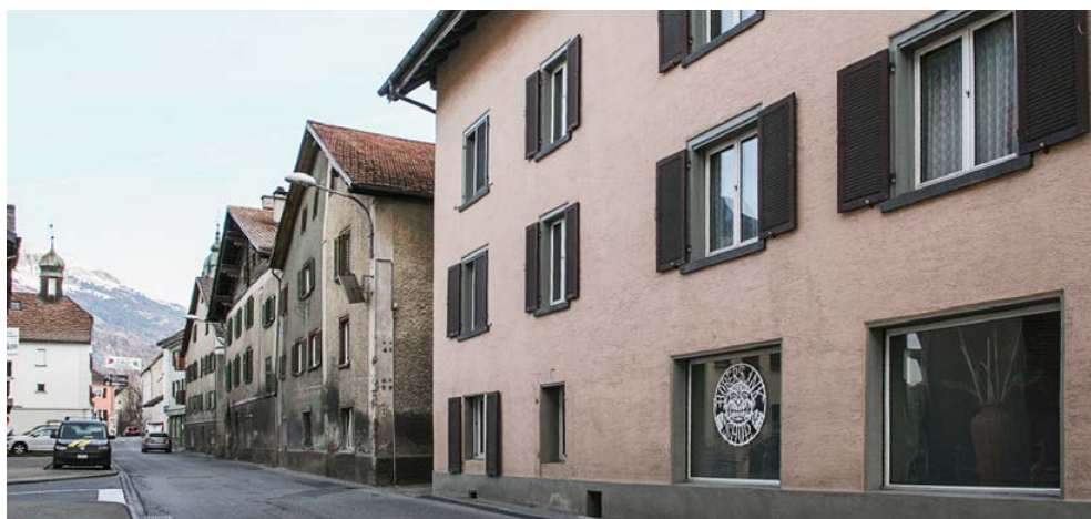
Das Haus Bonadurer (im Vordergrund) bleibt stehen, während die drei nächstfolgenden Gebäude abgebrochen und durch dreistöckige Wohnhäuser ersetzt werden.
