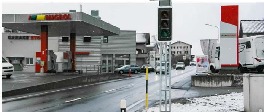
Am südlichen Dorfeingang steht diese teilautomatisierte Lichtsignal-Anlage, die dazu beiträgt, dass der Verkehrsfluss an Spitzentagen optimiert und gleichzeitig die Belastung für die Dorfbewohnerinnen und -bewohner reduziert werden. Bild Bartholomé Hunger
