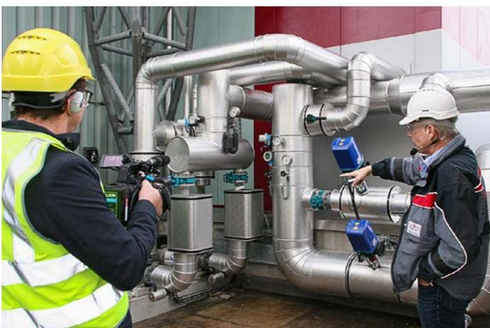
Dieses neu installierte Röhrensystem bildet einen Teil der Energierückgewinnung von Reingasen.
