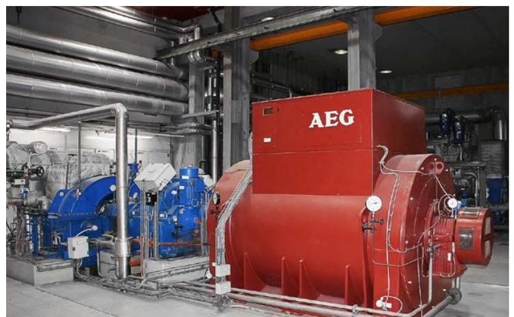
GEVAG produziert nicht nur Fernwärme, sondern mit zwei Dampfturbinen (Bild) auch elektrischen Strom.
