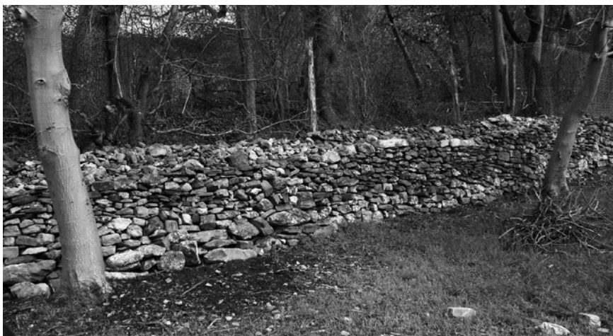
In etwa so sieht am Schluss die rund 250 Meter lange Mauer an der Ochsen-gasse aus.
