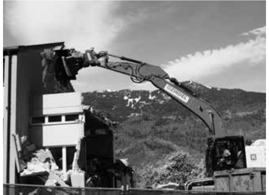
Die Abbrucharbeiten nahmen eine längere Zeit in Anspruch.
