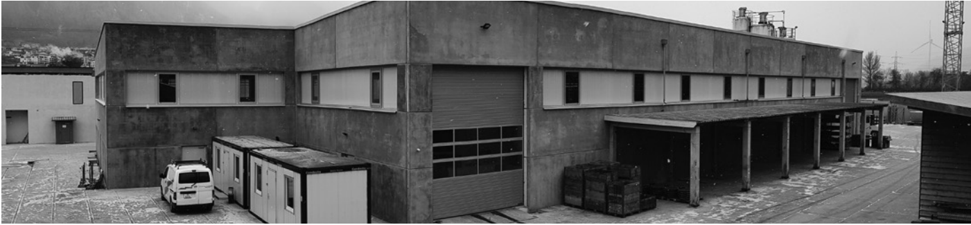
2017: Neubau und Erweiterung Industriehalle in Trimmis. Bauherr: TBA Trimmiser Baustoff AG. Gesamtplanung.
