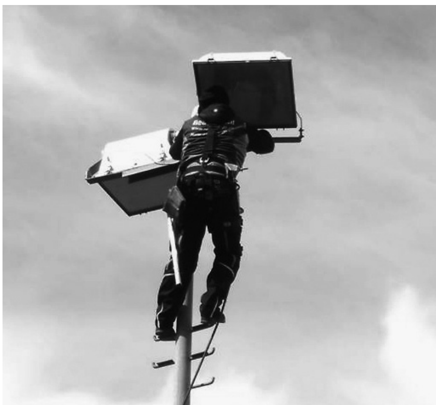
Die Montage der LED-Beleuchtung in luftiger Höhe ist nicht jedermanns Sache.
