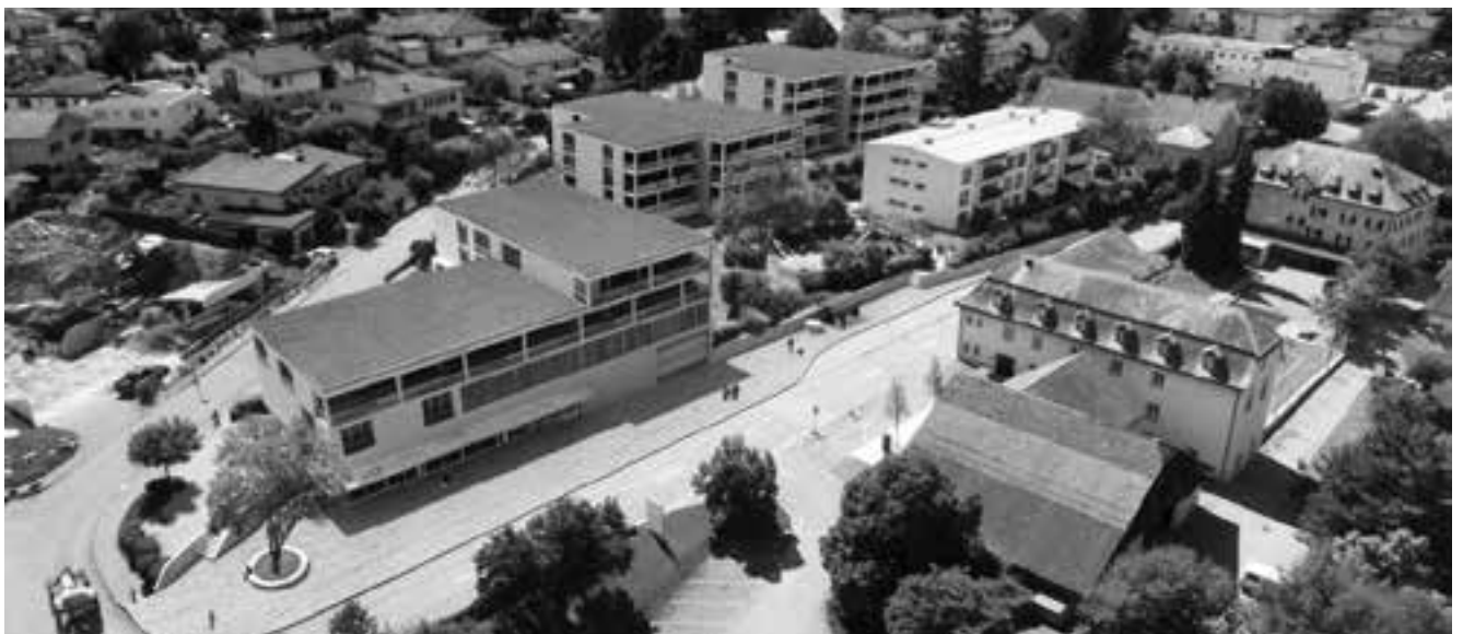
Die «roten Blöcke» zwischen Rang- und Kantonsstrasse wurden abgerissen und werden durch graue ersetzt.
