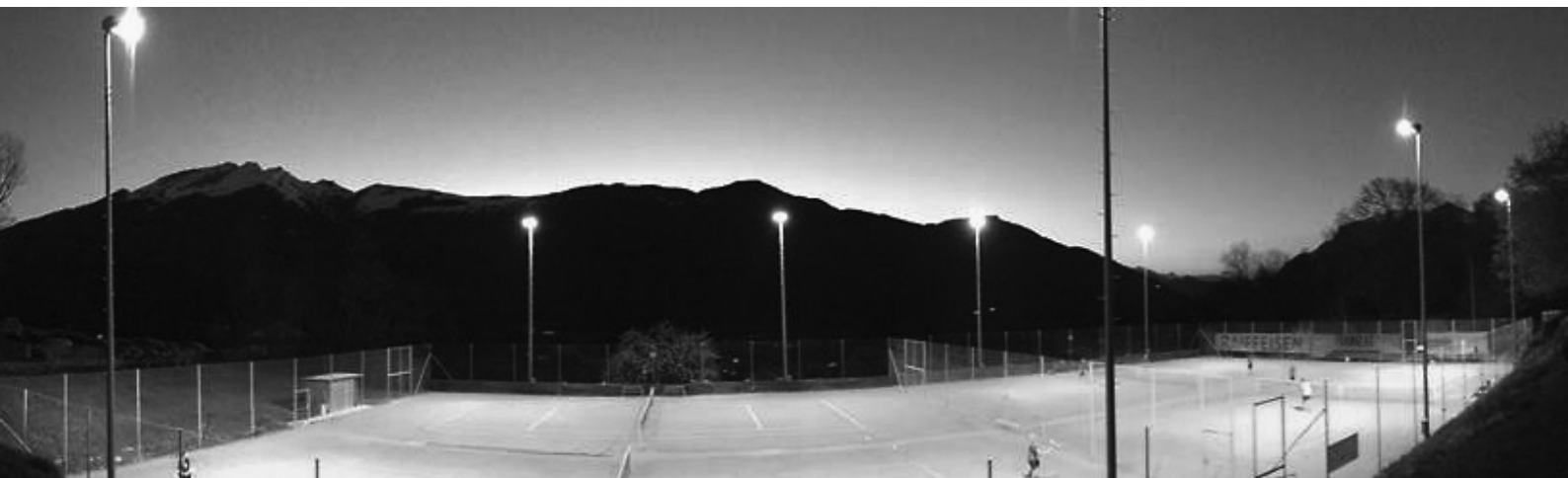
Die neue Beleuchtung ersetzt die beinahe vierzigjährige Beleuchtung, ist finanziell günstiger und verursacht weniger Strombedarf.
