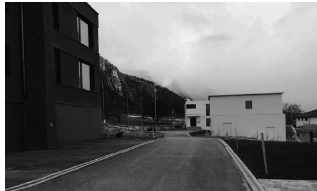
2008: Sanierung Quaderstrasse in Zizers. Bauherr Politische Gemeinde Zizers. Gesamtplanung.
